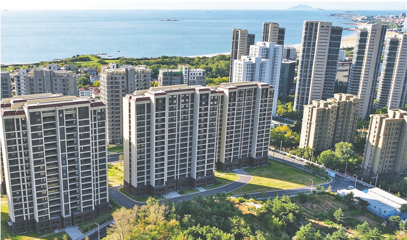
王家村社区改造安置项目进入竣工验收冲刺阶段。中铁建工集团供图
