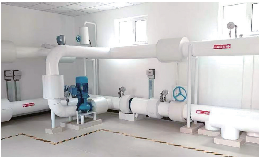
老旧小区换热站更新。
