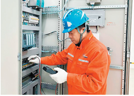
张生现场调试维修设备。
