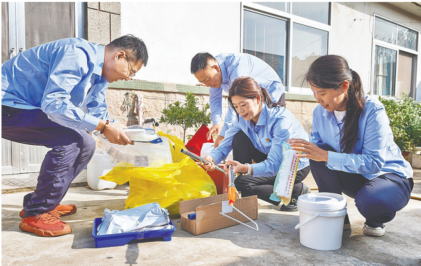
董巧艳(中)和同事粉刷帮扶老人家的墙面。
