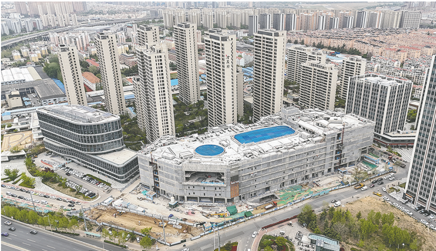
李沧吾悦广场正在加速推进各项工程建设。
