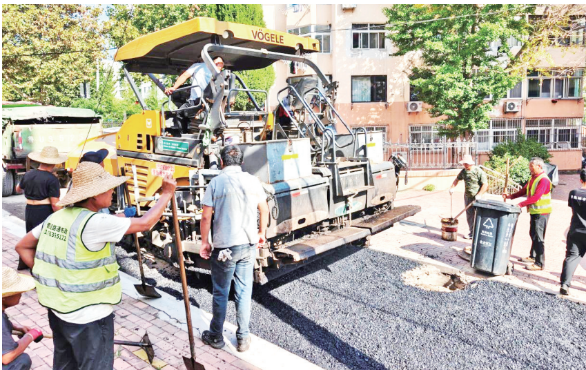
洛阳路街道聚馨苑小区正在铺沥青路面。 市北融媒供图
