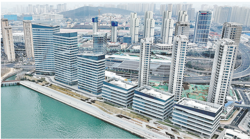
青岛人工智能集聚区北片区项目二期。青报全媒体/观海新闻记者 邢志峰 摄
