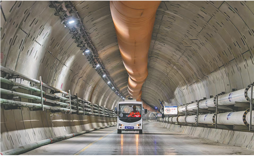
通勤车辆行驶在服务隧道成型隧道。参建单位供图
