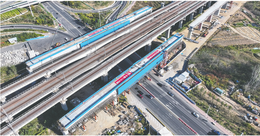
潍宿高铁至青岛连接线连续梁完工超九成。参建单位供图
