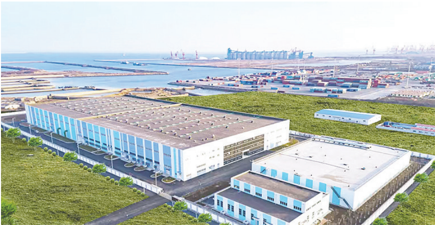
董家口海水淡化项目。
