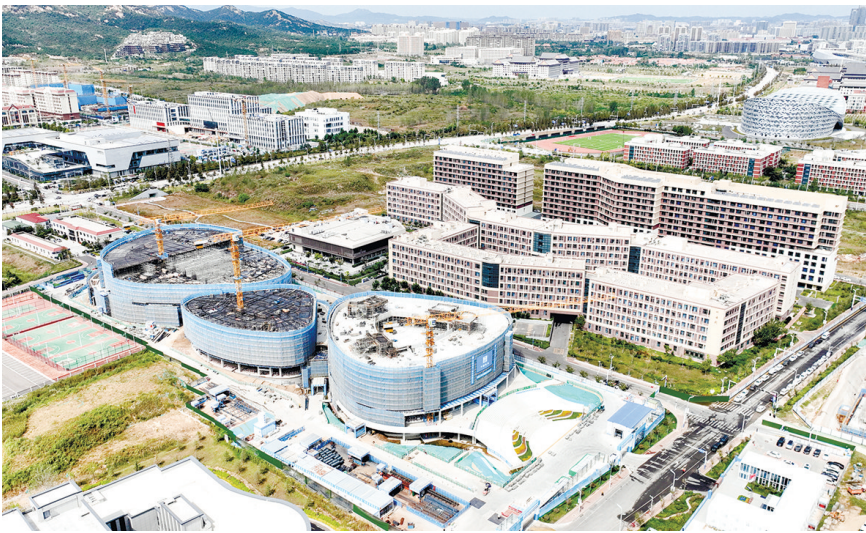
中国海洋大学西海岸校区大学生活动中心主体封顶。
