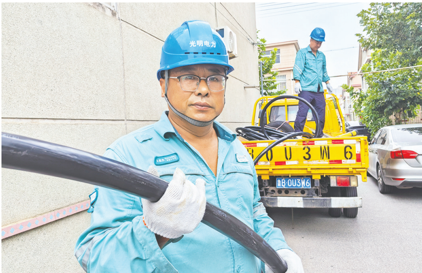
王君杰在即墨区龙山街道抢修现场。
