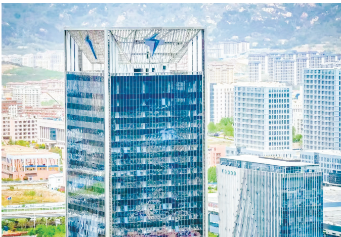
特锐德公司的“超阶零碳大楼”。 资料图片
