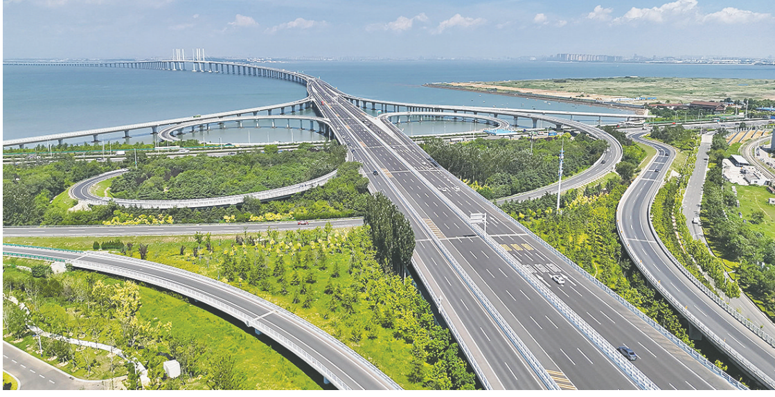
胶州湾大桥。市生态环境局供图
