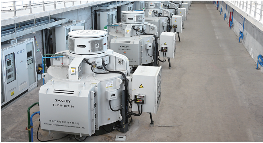
官路水库助力青岛实现“双渠双库”供水格局(组图)。
