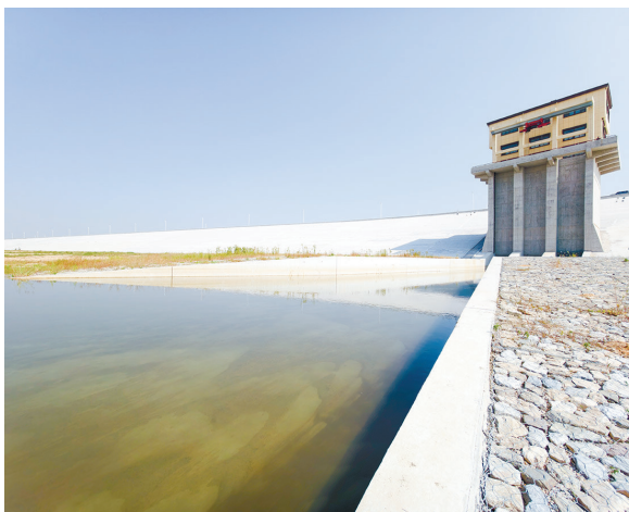
官路水库正式启动蓄水试运行。刘栋 摄
