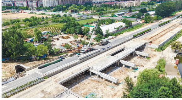
荣潍高速平度段改扩建工程现场。
