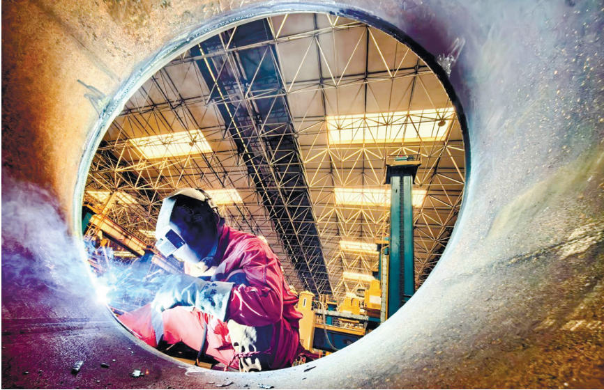
施工人员进行结构钢管的焊接作业。 海油工程供图
