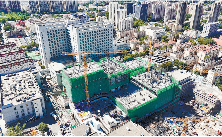
康复大学青岛中心医院二期改扩建项目建设现场。
