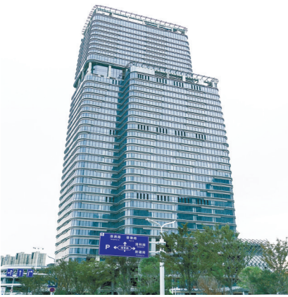
青岛国际邮轮港区航运中心项目预计明年6月竣工。 项目方供图
