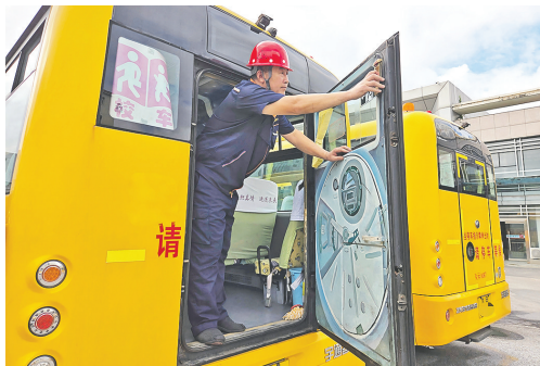
工作人员检修应急门等安全部件。
