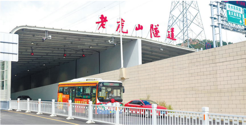
437路微循环公交车驶出老虎山隧道。
