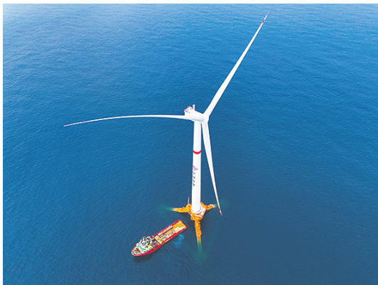
16兆瓦张力腿浮式风电平台投运。海油工程供图
