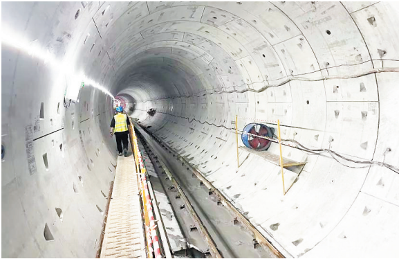
地铁5号线建设现场。地铁供图
