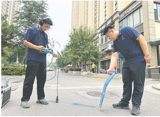
工作人员对小区管网进行排查。青岛水务集团供图
