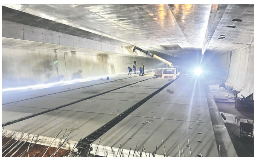
地铁5号线福宁立交站铺设站台板。地铁供图
