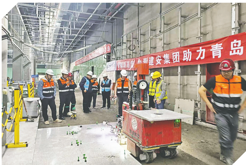
机器人上阵铺地面石材。地铁供图
