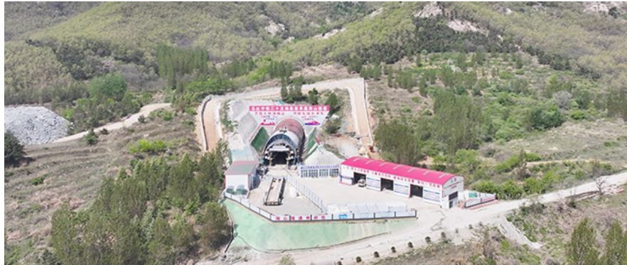
潍宿高铁至青岛连接线全线最长隧道贯通。市交通运输局供图
