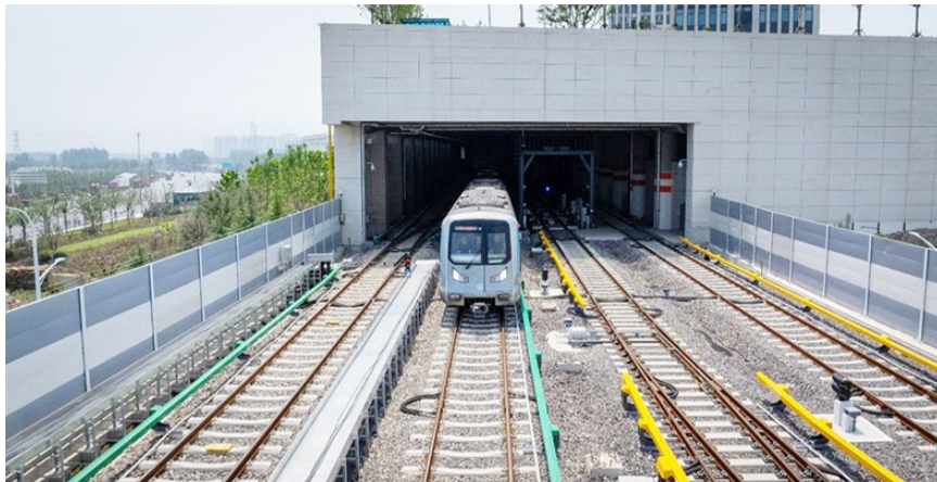
TACS列车上线运行。地铁供图
