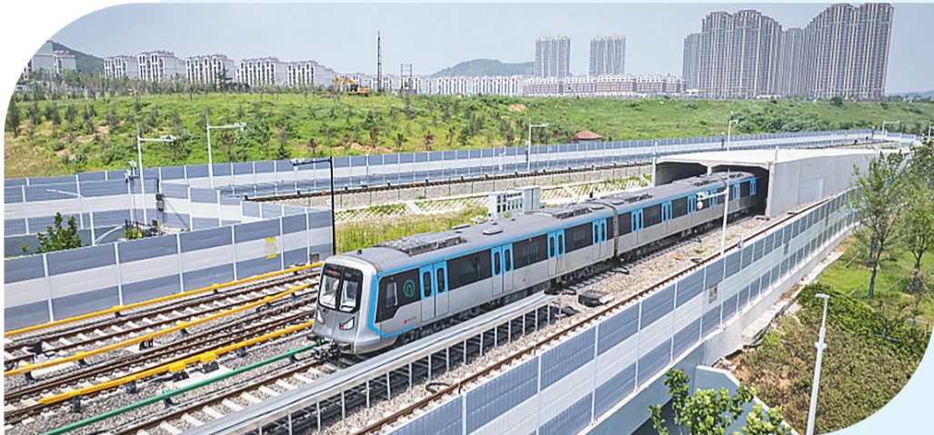
▲列车全自主运行系统(TACS)在青岛地铁6号线落地。
