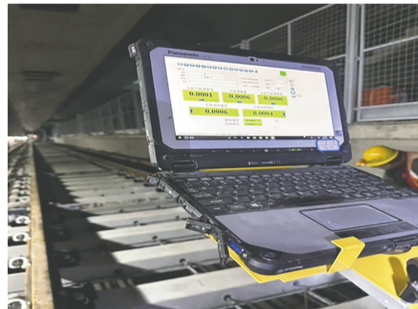
CPⅢ轨道精测小车指导钢轨精调作业。地铁供图
