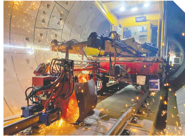
搭载燃料电池技术的焊轨设备实现环保与高效双赢。
