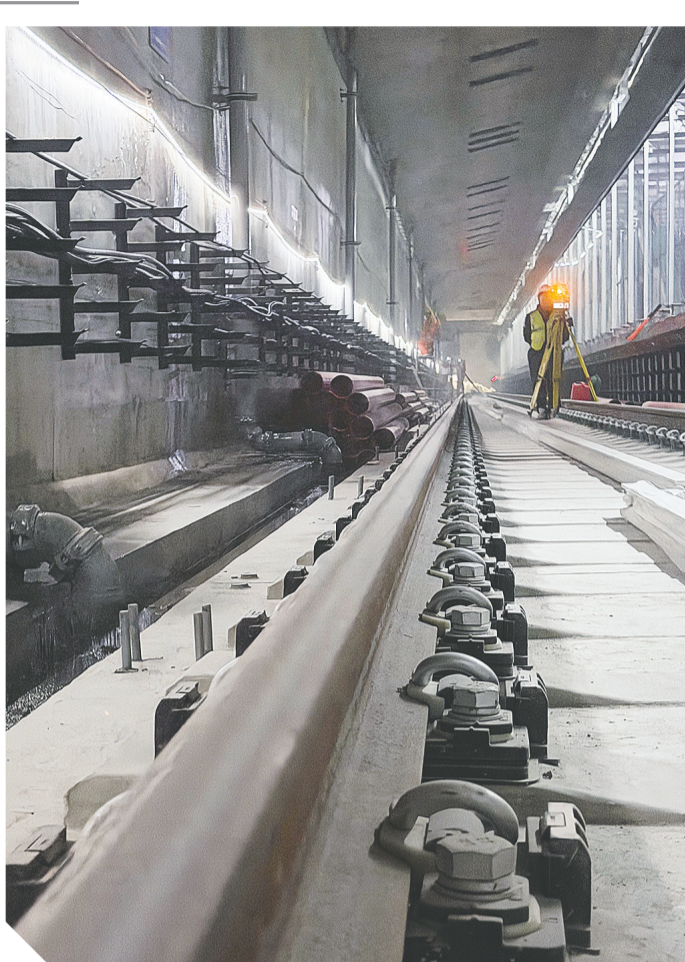
2号线二期铺轨作业突出“智绿融创”建造实践。周建亮 摄
