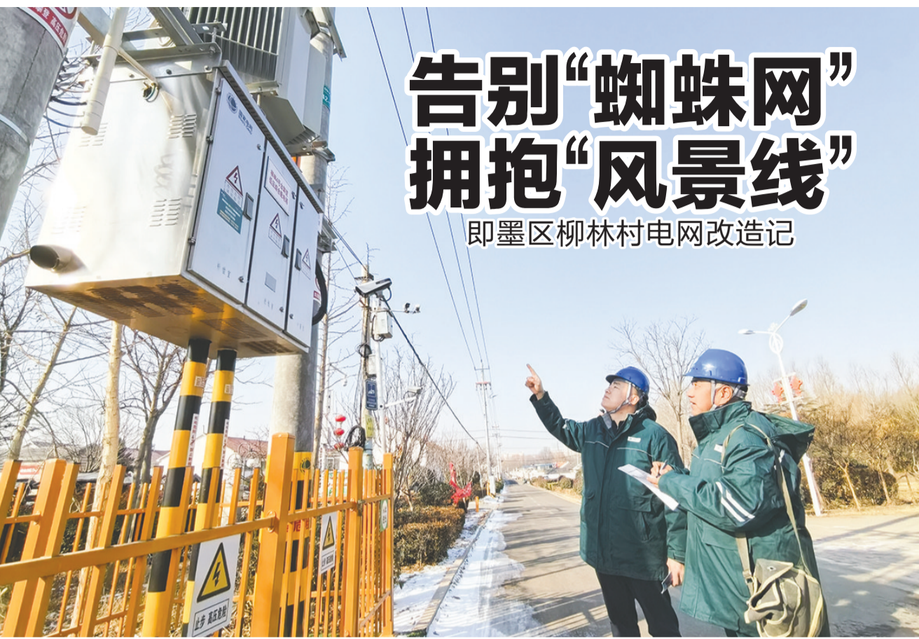
即墨区供电公司工作人员在柳林村查看改造后的电网。
