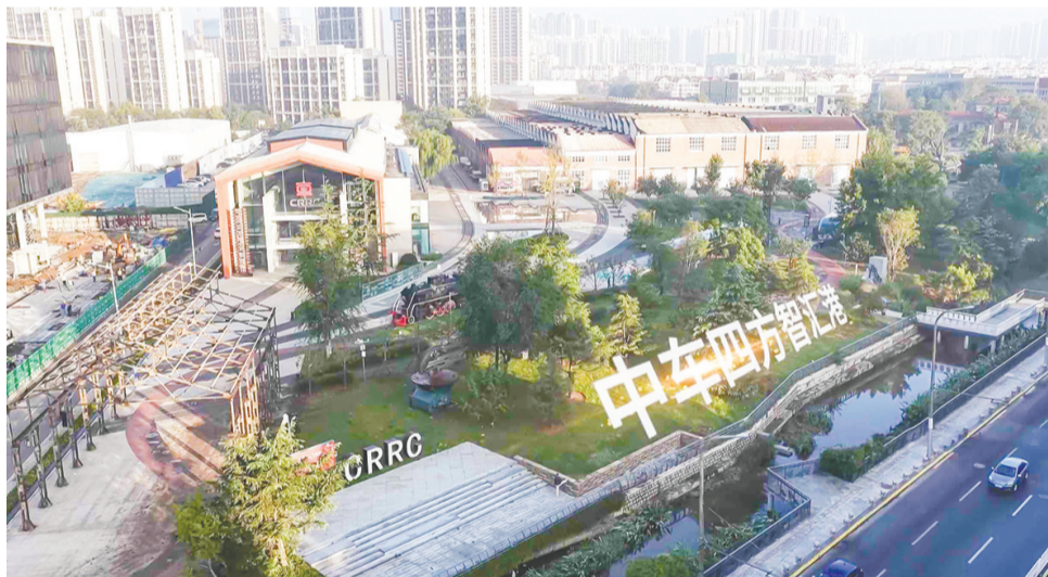
中车四方智汇港片区。市北区供图
