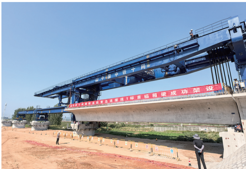
潍宿高铁至青岛连接线进入上部结构施工阶段。
