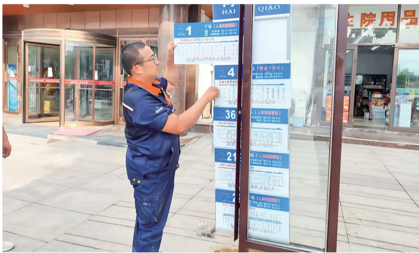
工作人员在海泊桥站安装新式龙门站牌。
