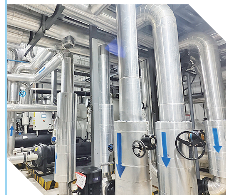
再生水制冷设备。
