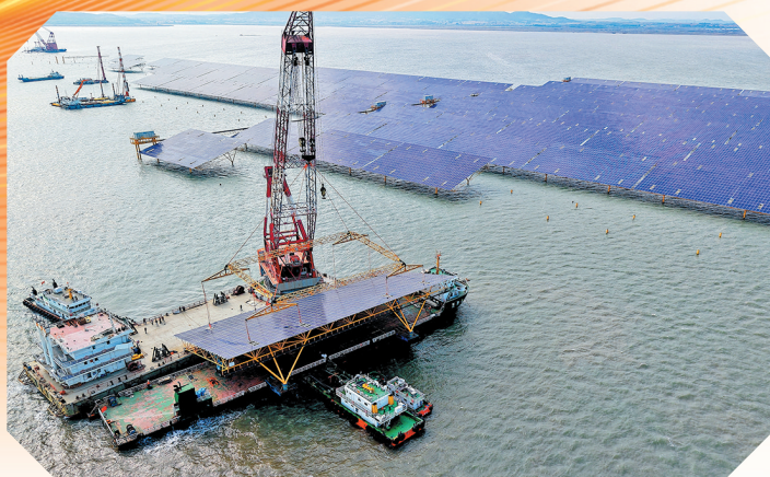
中电建青岛即墨海上光伏项目海上安装作业。
