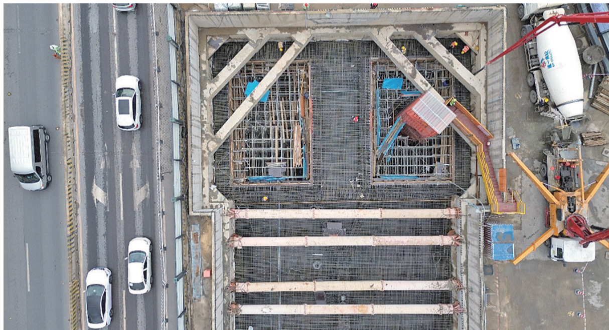
「湖景」地铁站正在加紧施工。地铁供图
