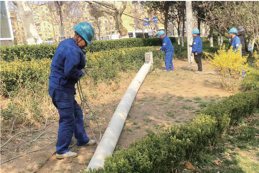
国网青岛供电公司工作人员移除废弃线杆。
