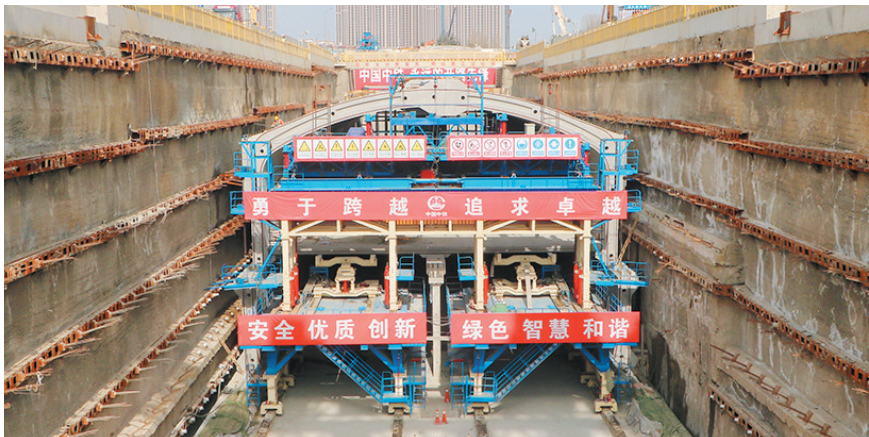
正在施工的地铁装配式车站。 资料图片
