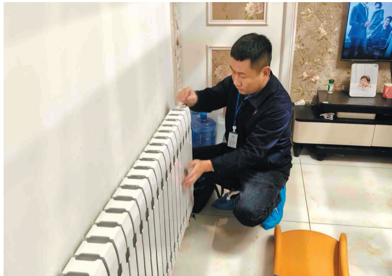
盛瑞城到用户家中检修管道。
