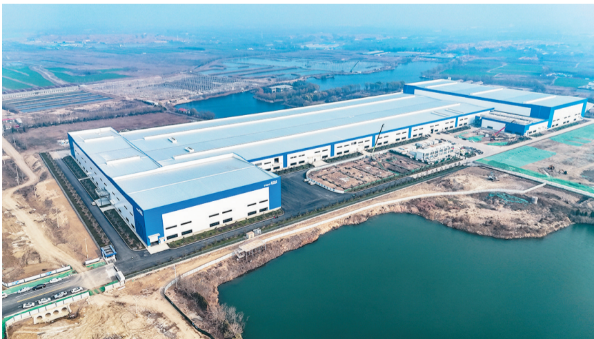
城阳区打造占地2000多亩的新能源产业园。
