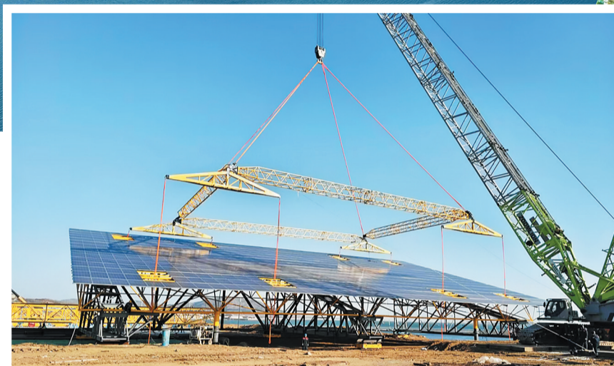
组图:中电建青岛即墨海上光伏项目海上部分开工建设。
