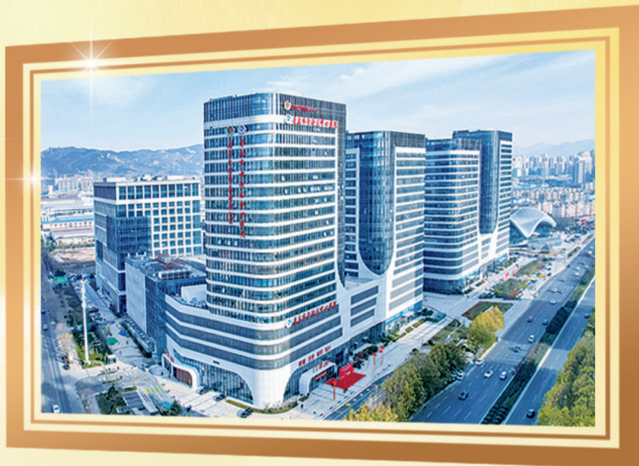
李沧区中心医院新院区启用。
