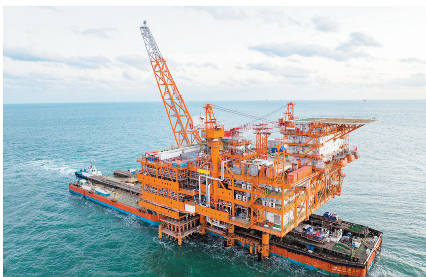
渤中26-6油田开发项目(一期)中心平台。海油工程(青岛)供图
