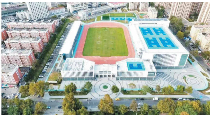
弘诚体育场停车场项目提前完工。市北融媒供图
