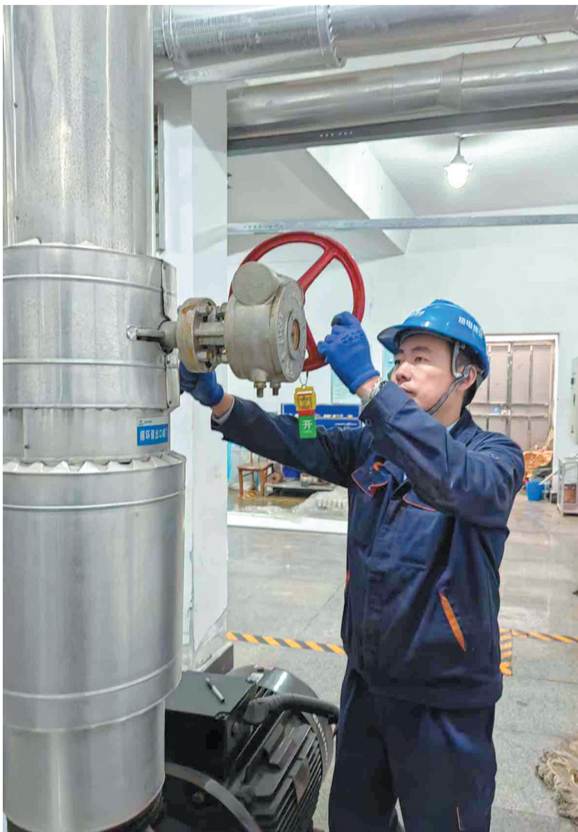
青岛能源热电集团福东换热站“供热管家”刘杰在检修管道。
