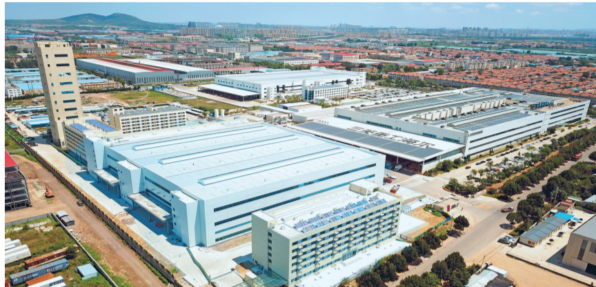
青岛三菱重工海尔空调产业园。
