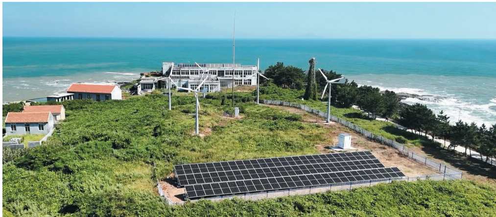
即墨区供电公司坚持创新驱动高质量发展，在大管岛建成投运“海岛绿电”科技项目。
