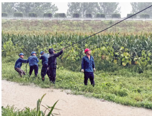
迎峰度夏期间，即墨区供电公司员工雨中抢修受损线路。
