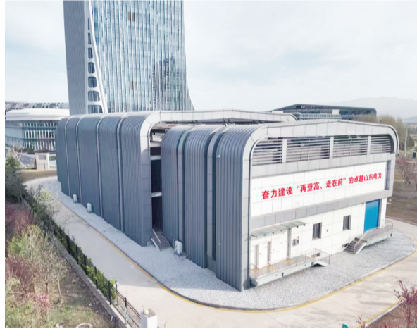
为蓝谷区域国家海洋实验室等“国字号”大项目供电的110千伏蓝谷站。
