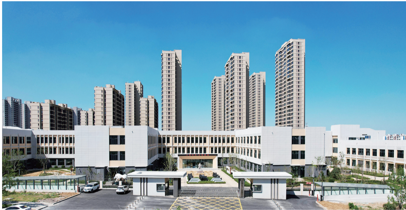
新建即墨区桃源小学。
