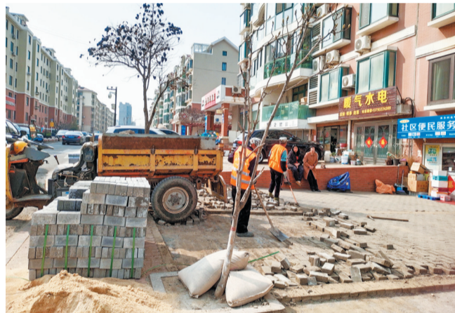
即发阳光城社区党委对社区破损路面进行修补。
