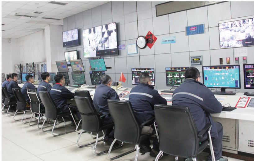
智慧供热软件平台。
