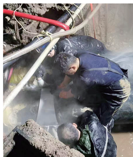
供热抢修现场。
